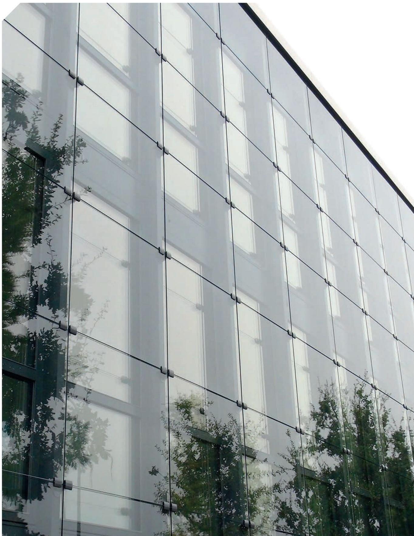
Bürogebäude, Karlsruhe-Durlach, Deutschland / Office building, Karlsruhe-Durlach, Germany
