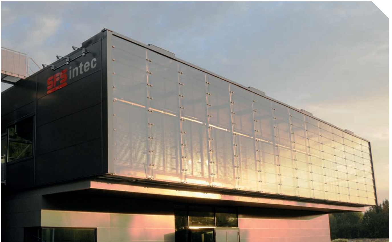
Betriebsgebäude, Helsinki, Finnland / Commercial premises, Helsinki, Finland
