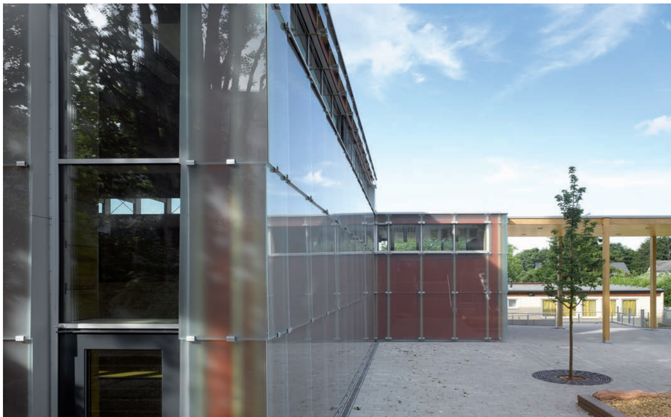
Zentgrafenschule, Frankfurt am Main, Deutschland / Zentgrafen school, Frankfurt on the Main, Germany
