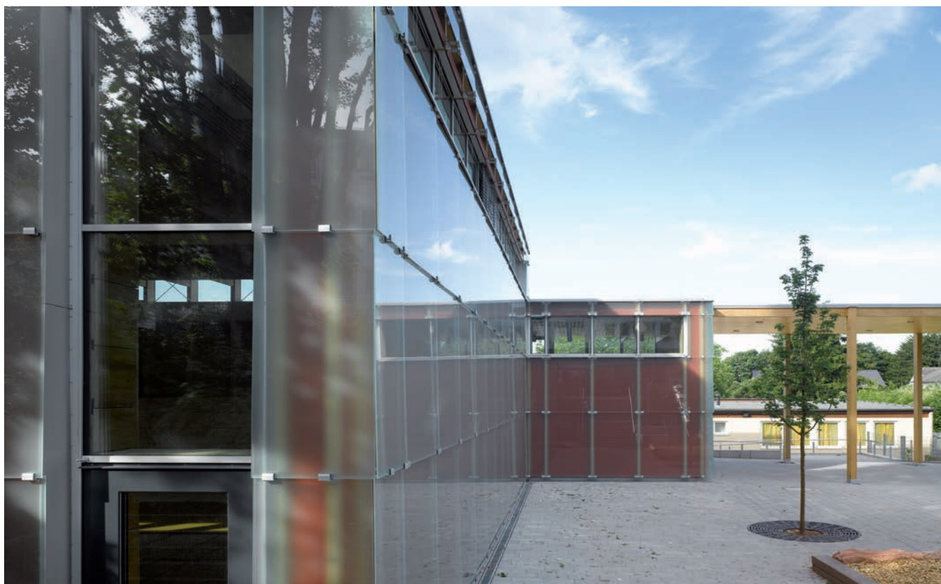
Zentgrafenschule, Frankfurt am Main, Deutschland / Zentgrafen school, Frankfurt on the Main, Germany
