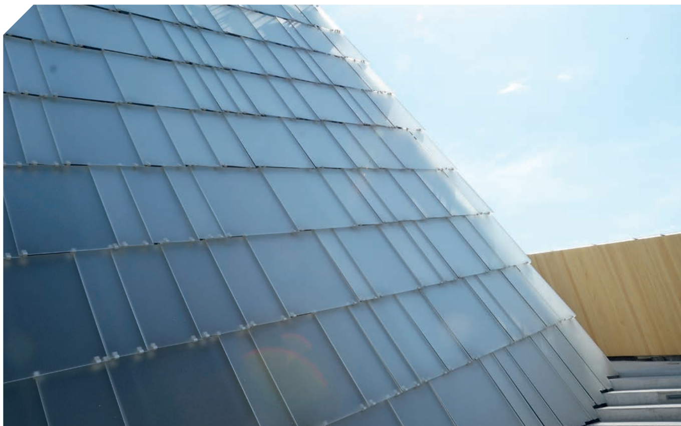
Gemeindezentrum & Kirche, Rif, Österreich / Community centre & church, Rif, Austria
