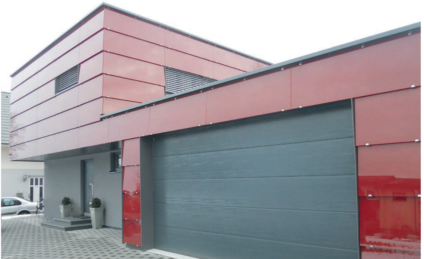
Einfamilienhaus, Hohenems, Österreich / Detached house, Hohenems, Austria
